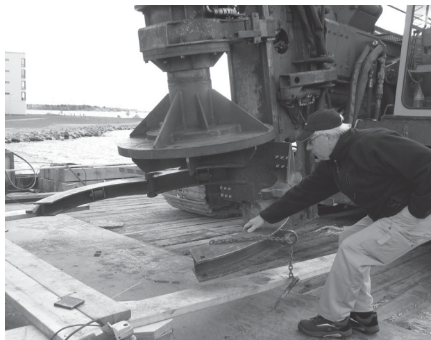
Kranen har försett med nya fångstarmar för att klara rördimensionen. Gert Andersson demonstrerar.
