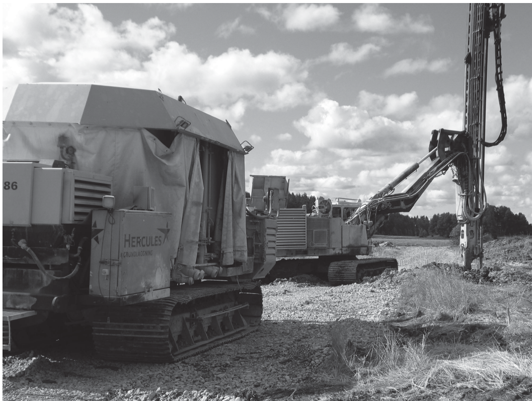
På denna plats pågår installation av kalkcementpelare för den del av anläggningen som ska bli uppställningsplats och väg för flistransporter till värmeverket.
