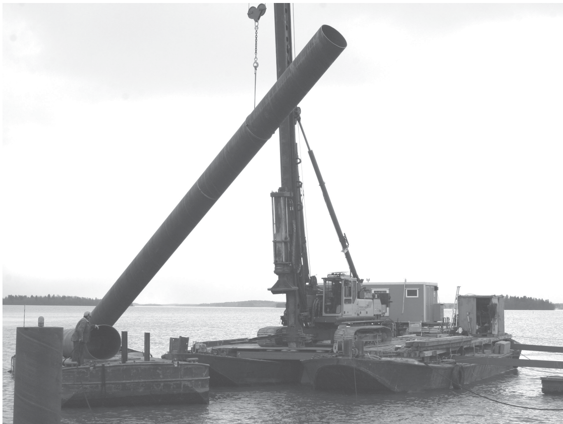
Det är ett spänningsmoment varje gång ett rör ska resas – att hantera 12 dinglande ton från flytande underlag kräver sin man. Och en hel del justeringar av utrustningen för att få rätt balans.
