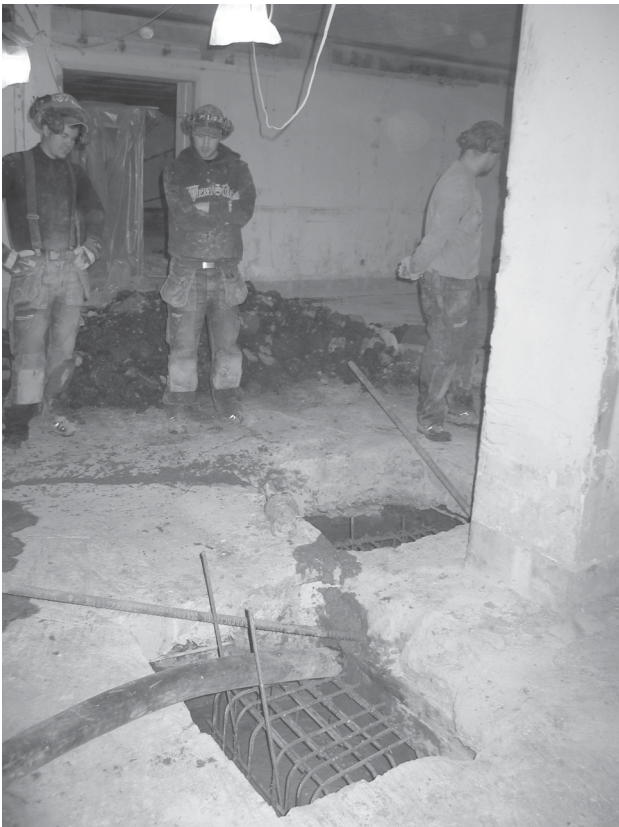
Urschaktat. Gjutning pågår. Fr v Joakim Höök, Erik Strandberg och Kristofer Larm.
