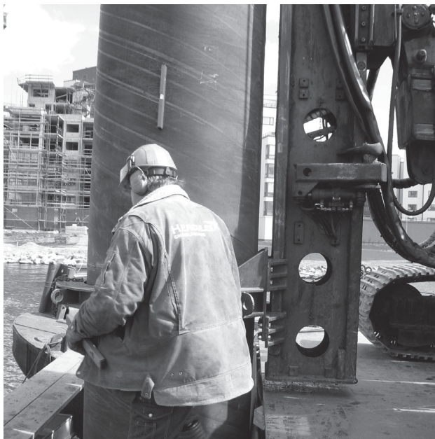
För att vara säker på att läge och lutning blir rätt mäter man från kajen efter varje slagen meter i början och mot slutet efter varannan meter. Benny Strandberg monterar monterar mätutrustning på pålen.
