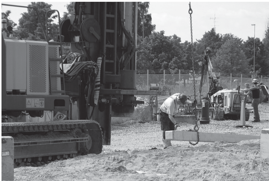
Örjan Jansson förbereder för lyft av pålen.
