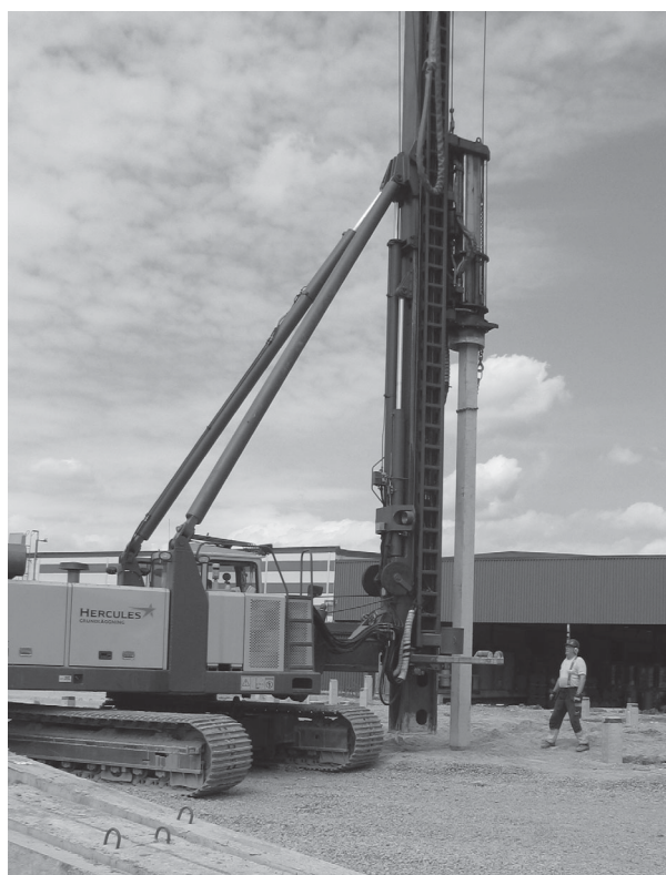
Robert Werme kör PB72 – HG 650, försedd med SuperRam-hejare. Imponerande drivningsförmåga!
