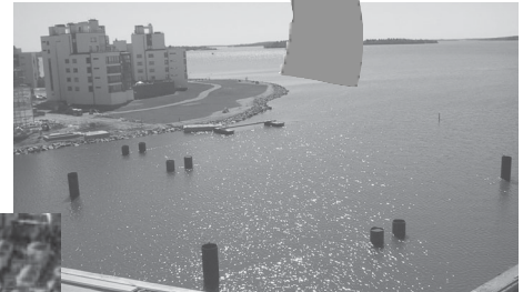
Tre par pålar för bron och nio dykdalber är uppdraget. Till sist ska det bli som till vänster (montage).
