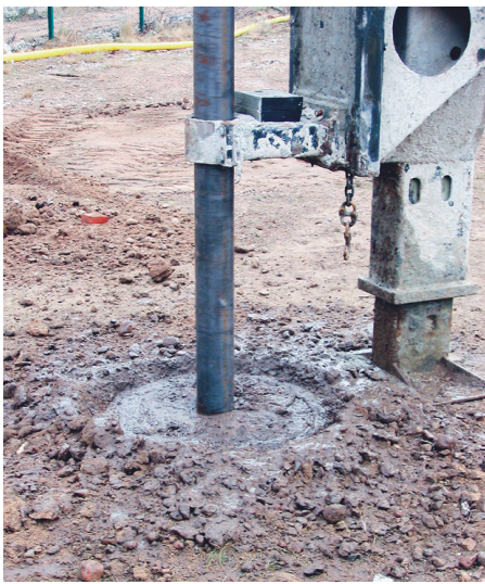
Bild 3: Installation av provpålar och intrimming av systemet.
