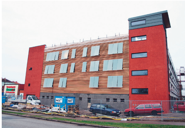
Bild 1: NCC byggde parkeringshus till AB Nissastaden i Halmstad. Huset grundlades på MDM-pålar, en innovativ vidareutveckling av KC-pelarmetoden.
