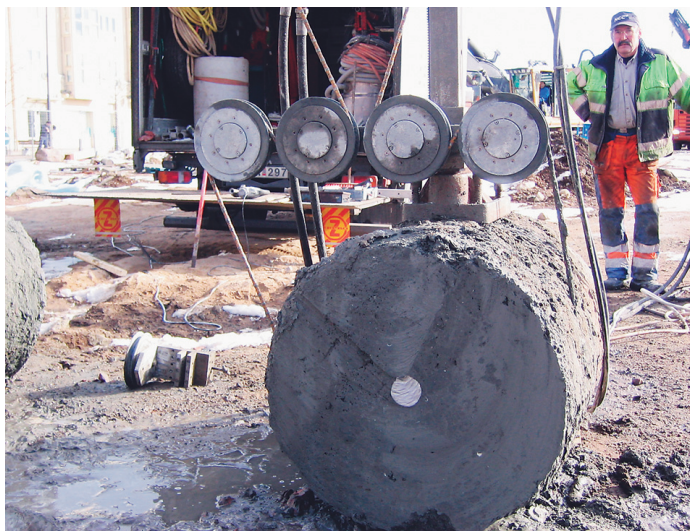
Bild 14: Uppdragen påle som kapas med kedjesåg för visuell kontroll av homogenitet.
