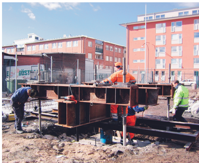
Bild 9: Montering av mothållsbalkar för statisk provbelastning av MDM-pålar.
